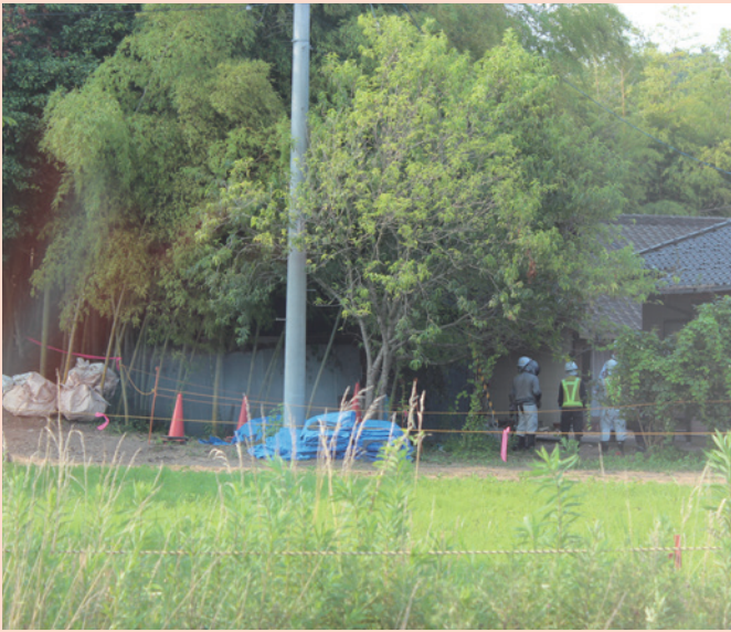
除染作業中の作業員たち
