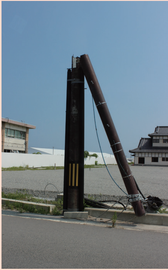
真つ二つに折れた電柱
