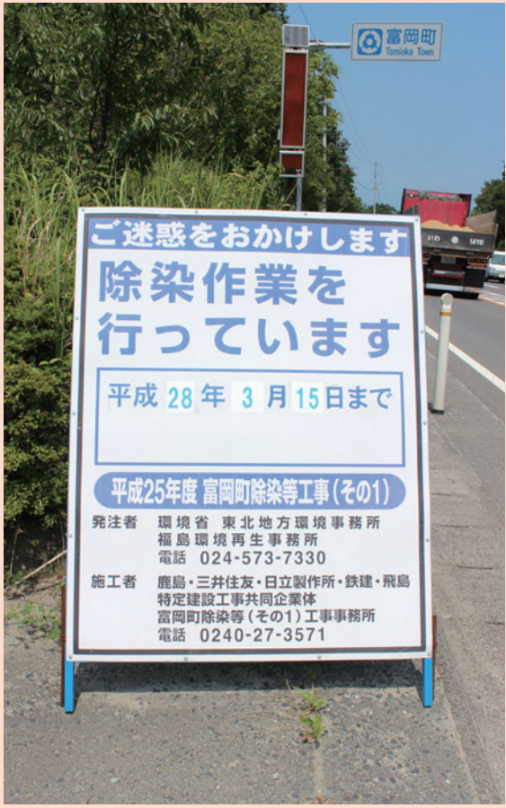
除染作業中の看板とダンパーカー
