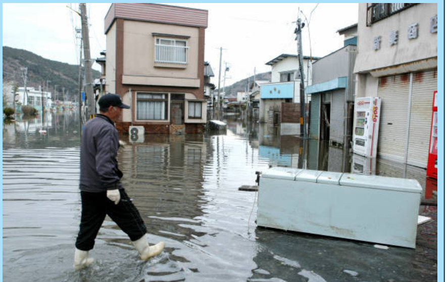
東日本大震災地震で地盤沈下した結果、大潮時には浸水 (石巻市)・・・jijicomより
