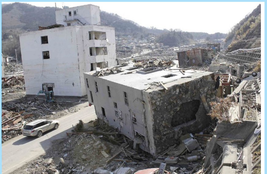
東日本大震災時の津波で倒れた女川の建物・・・日経XTECH より
