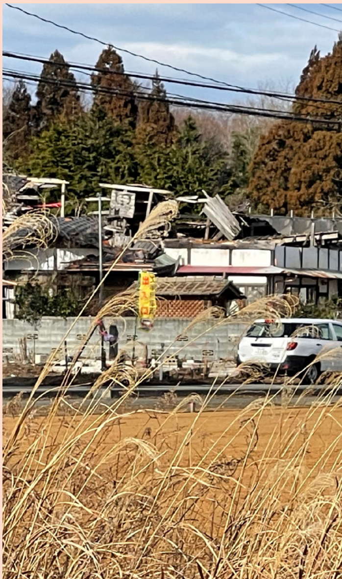
大震災で破壊されたそのままに放置されている家屋・・・2023年1月 筆者撮影
