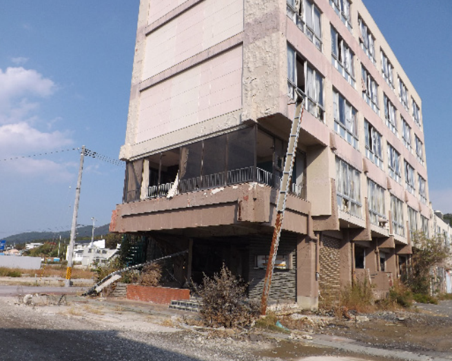
大震災1年7ヶ月後の牡鹿半島鮎川一被災した建物放置
