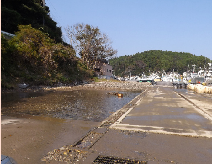
大震災1年7ヶ月後の牡鹿半島小淵一1mほど地盤沈下した岸壁
