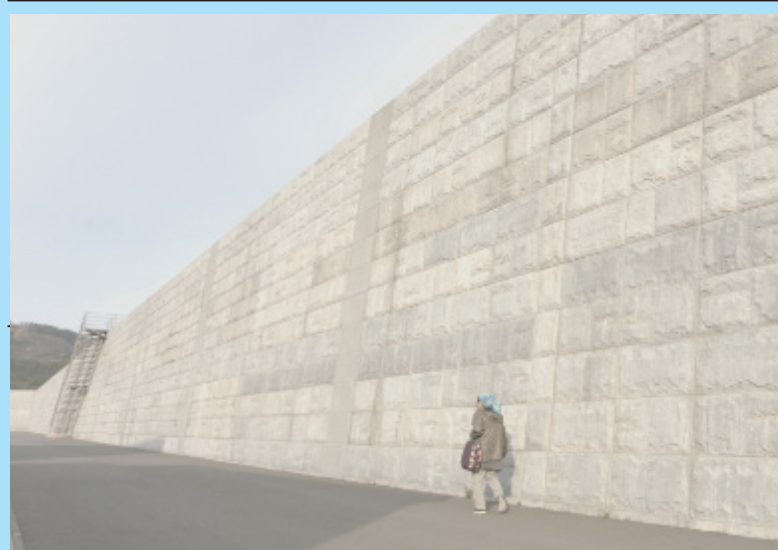
【まるで刑務所】というあだ名が嘘ではない高すぎる防潮堤・・・NHKBS 放送より
