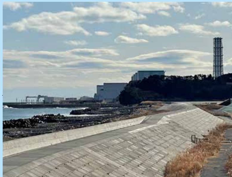
福島第2 原発遠景と堤防工事
