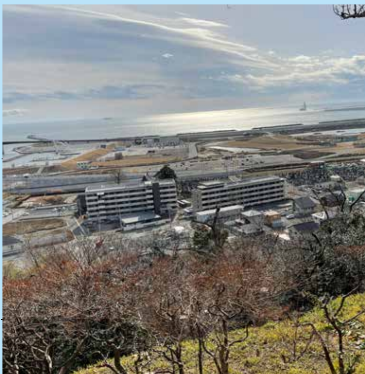
公園化工事が進む宮城県石巻市南浜地区遠景
