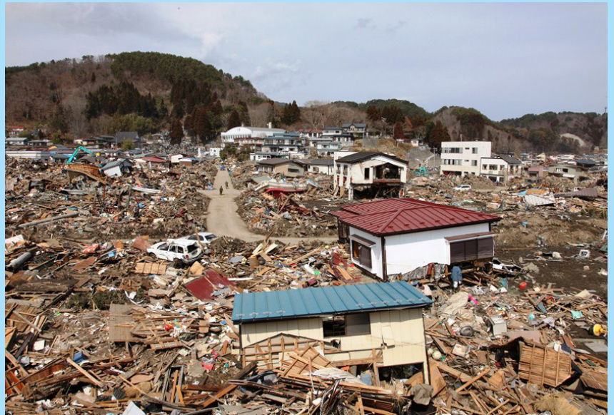
田老町の被害
