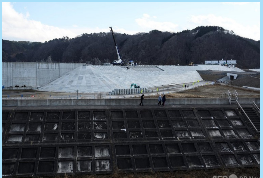
新たな防潮堤工事
