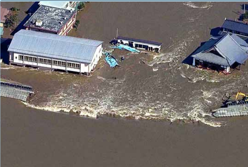
令和元年 台風 21 号宮城県大郷町堤防決壊
