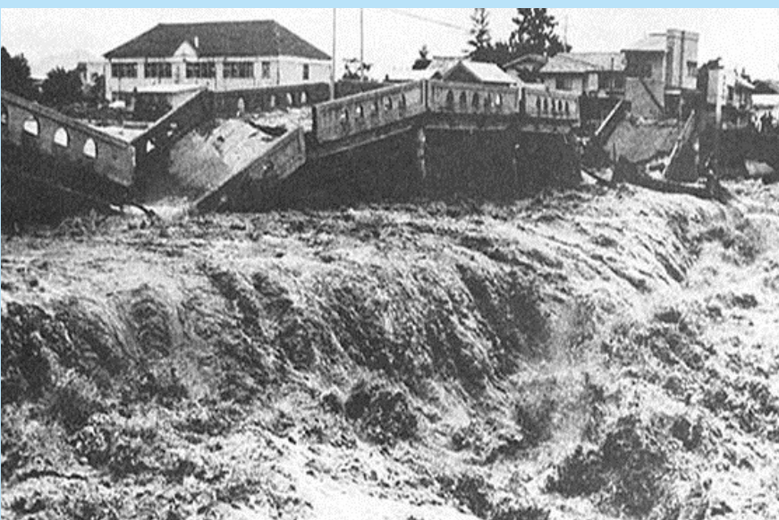
昭和 50 年 津軽・十和田湖周辺大雨被害
