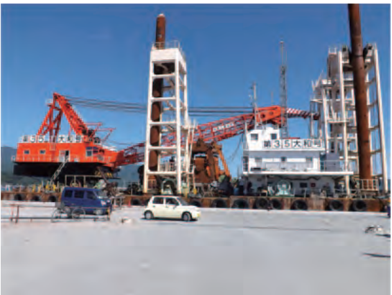
山田-巨大ながれき撤去機械
